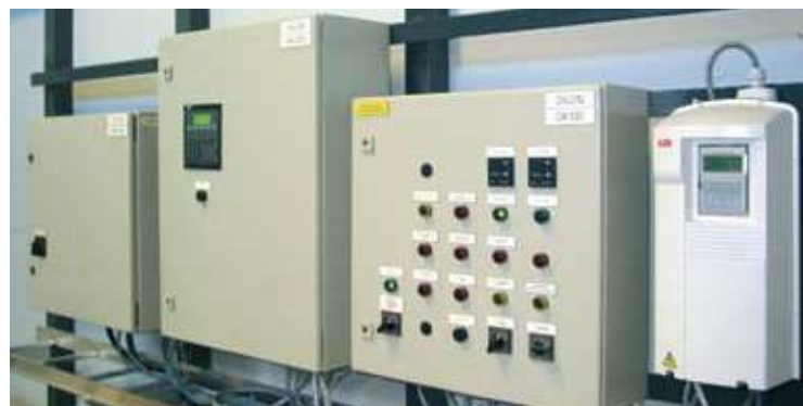
Automatyka palnika „All-inclusive”: kontrola O 2 /sterowanie ciśnieniowe/sterowanie kaskadą
